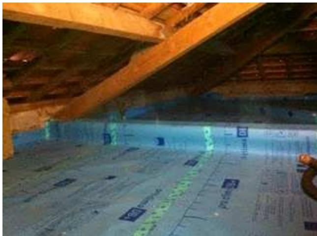
Mise en place d'un frein vapeur pour assurer l'étanchéité à l'air du bâtiment, et abaisser la pression de vapeur intérieure avant que celle-ci ne traverse l'isolant.
