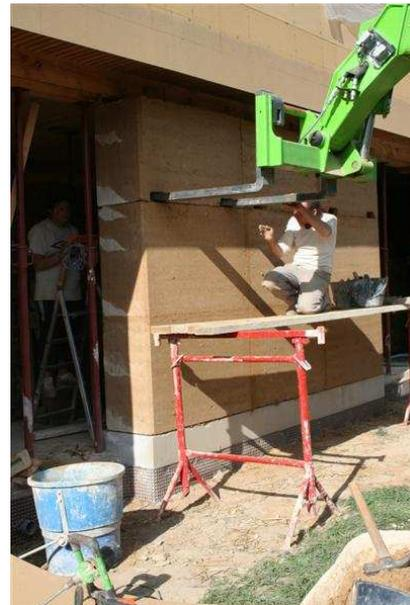
**Mise en place d'un bloc de pisé préfabriqué, source F. Streiff**
