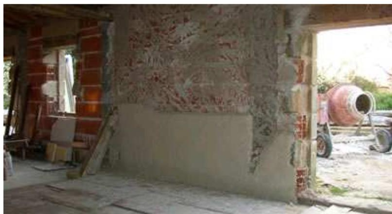
Rénovation énergétique d'un bâtiment ancien grâce à l'application d'un enduit chaux chanvre.
